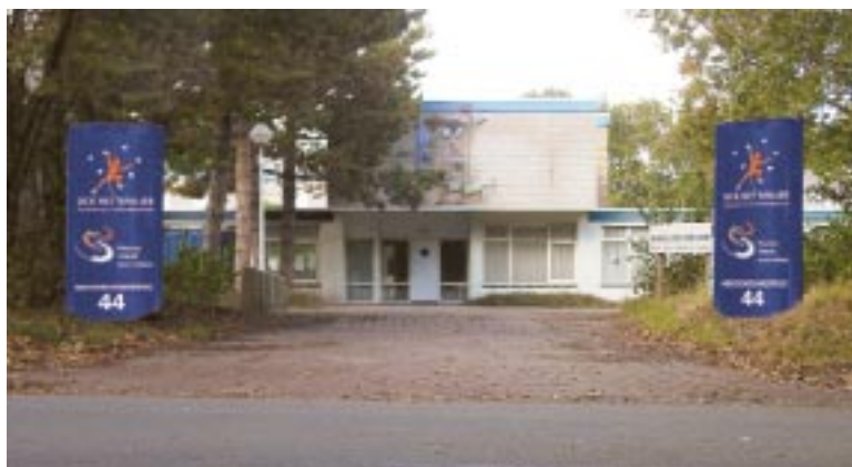
Centraal bureau Santpoort-Noord, betrokken in april 2004
